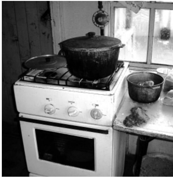
Рис. 1. - Газова плита, що працює на біогазі
