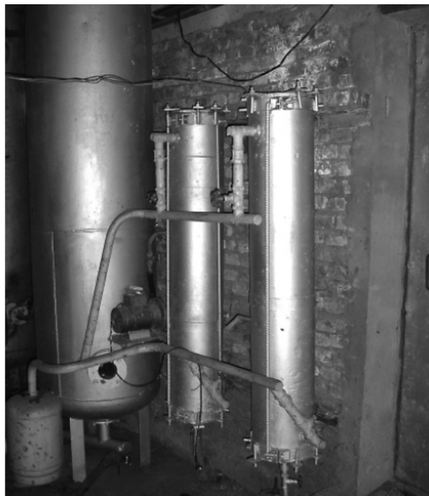
Рис. 5. - Сірководневий фільтр і абсорбер для відділення вуглекислоти
