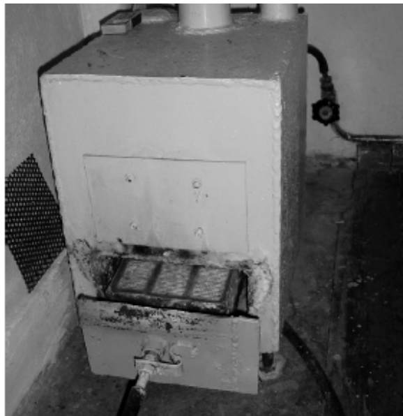
Рис. 1. - Газова плита, що працює на біогазі
