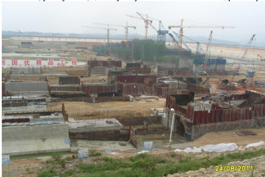
Рис. 6. Широкомасштабне будівництво гідроелектростанції в Китаї
