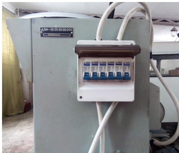
Рисунок 1.4 – Блок керування потужністю споживачів електроенергії
