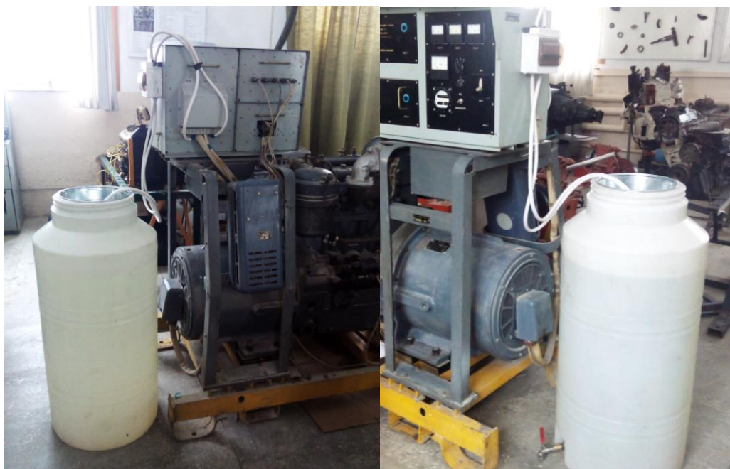
Рисунок 1.3 – Резервуар з водою об'ємом 200л із зануреними в неї електронагрівачами
