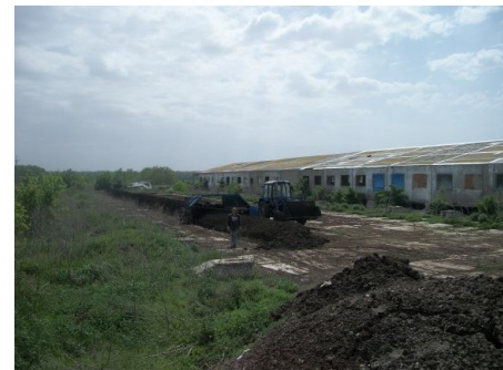
Рис. 4. Загальний вид майданчику з твердим покриттям
