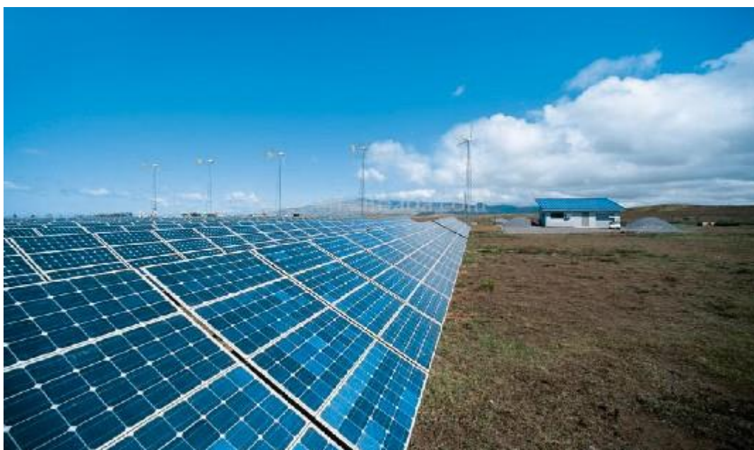
Рис. 1.14. Модульний тип фотоелектричних перетворювачів дозволяє створювати установки будь-якої потужності й робить їх дуже перспективними
