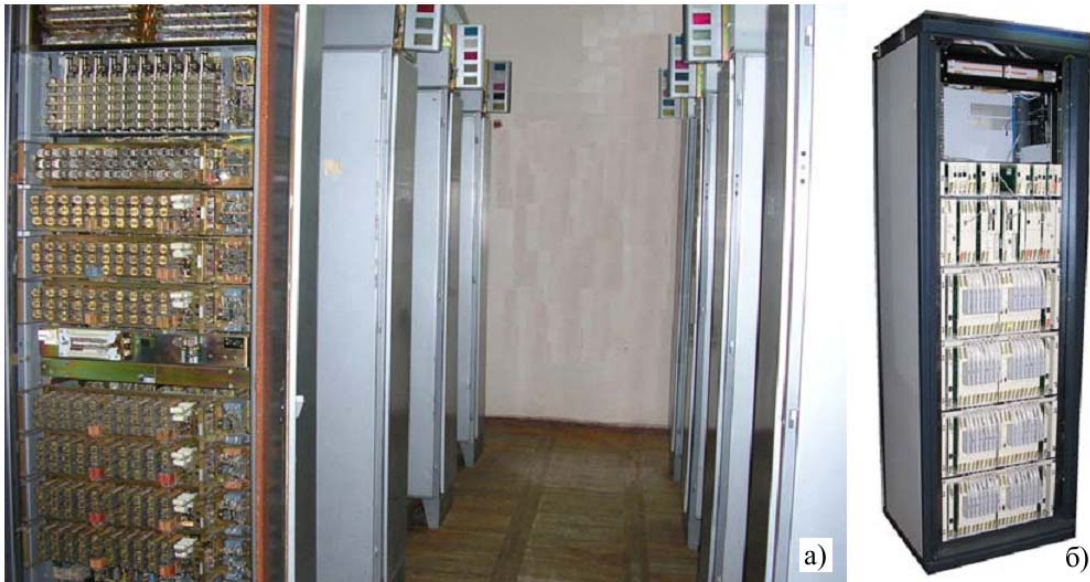
Мал. 1.69. Електромеханічна (а) та цифрова (б) АТС
